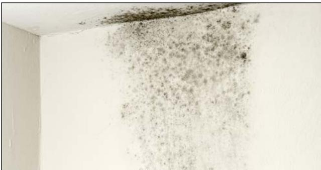
Figura: Angolo con formazione di muffa
