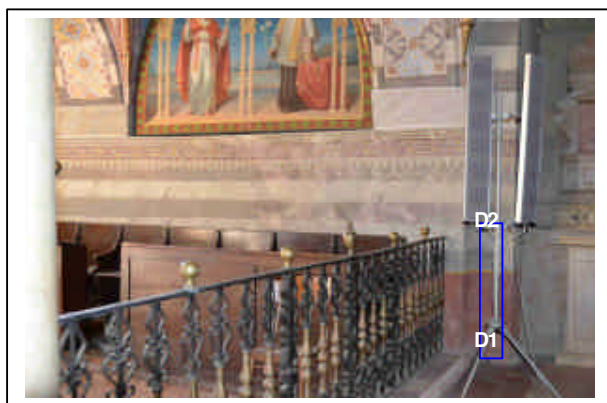
Figura 3 - Parete sud, zona D
