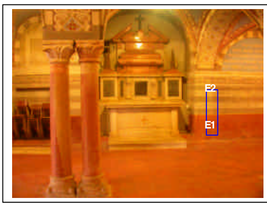
Figura 4 - Parete sud, zona E
