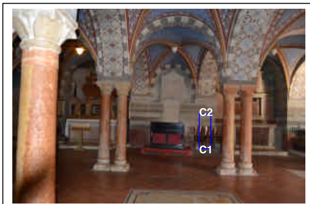
Figura 2 - Parete nord, zona C
