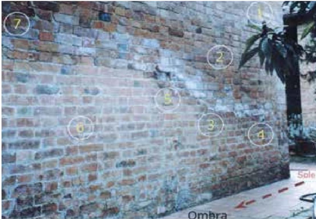
1. zona del muro asciutta; 2. zona mantenuta bagnata da vecchi sali igroscopici interni; 3. linea dell'attuale fuoriuscita; 4. linea bassa per maggiore evaporazione dovuta alla maggiore esposizione al sole; 5. linea più alta per minore evaporazione all'ombra; 6. zona saturata di cristalli interni apparentemente asciutta; 7. mancanza di fuoriuscita per ridotto apporto a quell'altezza.
