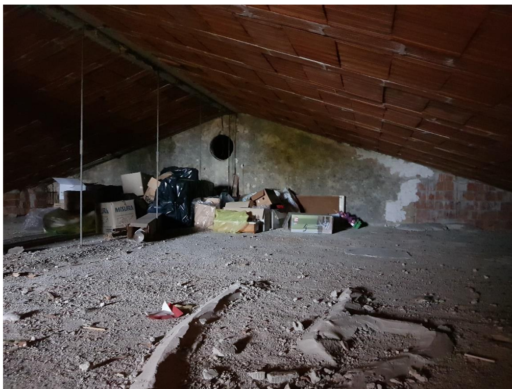
Sottotetto per il passaggio dei canali (N: i canali andranno poi ricoperti con materiale di coibentazione del solaio)
