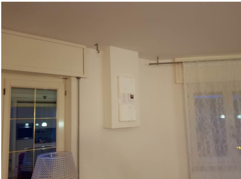
Rivestimento della controcassa in cartongesso. Si vede la protezione in polistirolo che poi viene rimossa ad opere finite
