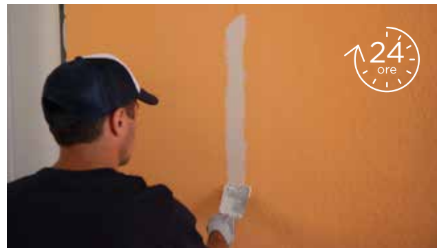
14 Stuccare i teli Isobell affiancati. (**Stendere a rullo il primer Siprime). Lasciare asciugare per almeno 24 ore
