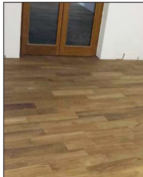
Dettaglio finitura in parquet posato su sistema FinoTherm® FINO
