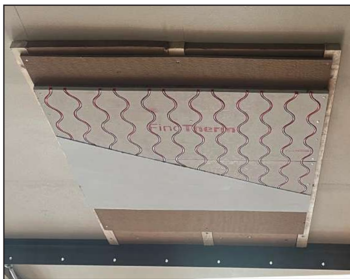
Dettaglio sistema radiante a soffitto FinoTherm ® KAPPOTTO con orditura con listelli di legno e rasatura finale
