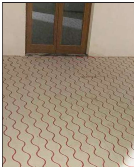
Dettaglio pannelli FinoTherm® standard posati
