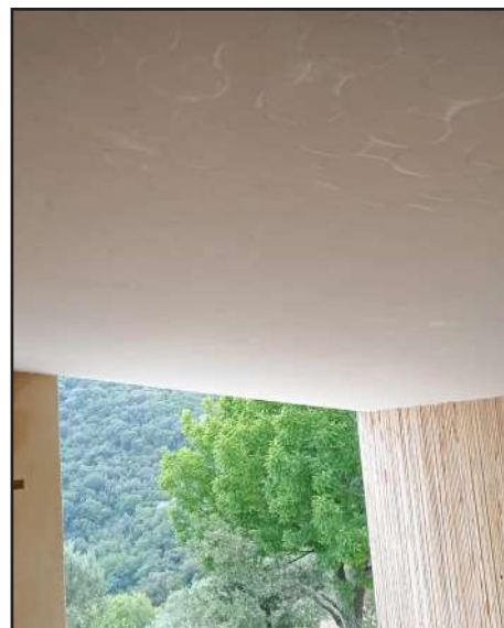
Dettaglio rasatura della superficie
