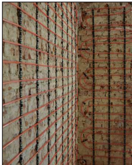
Posa della tubazione nelle intersezioni delle barre modulanti
