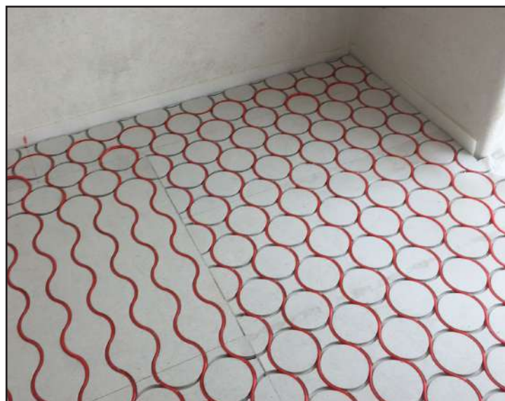
Posa della tubazione
