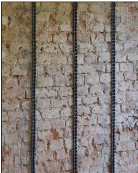
Fissaggio barre modulanti su muratura esistente
