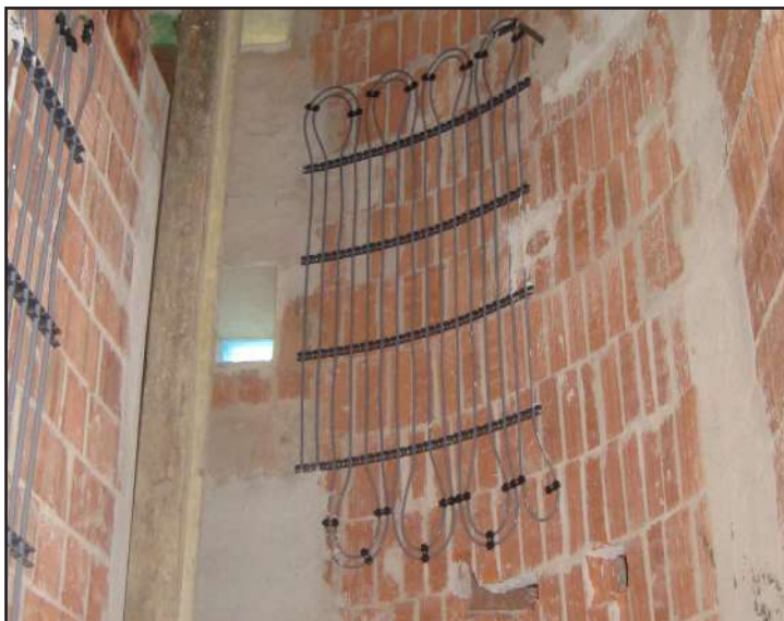
Fissaggio barre modulanti e tubazione su superfici curve e irregolari
