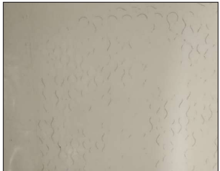
Finitura della parete con intonaco
