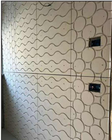
Dettaglio posa pannelli FinoTherm® in gessofibra a parete
