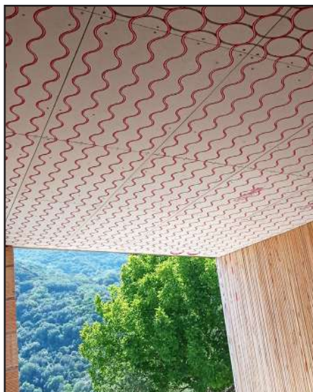
Dettaglio posa della tubazione
