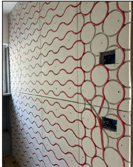
Posa della tubazione
