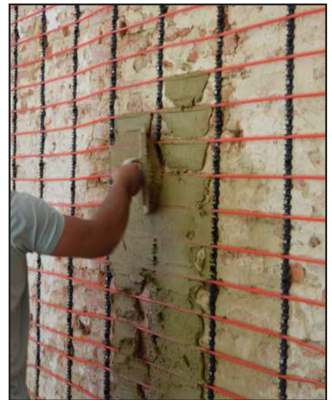
Applicazione intonaco in argilla su parete
