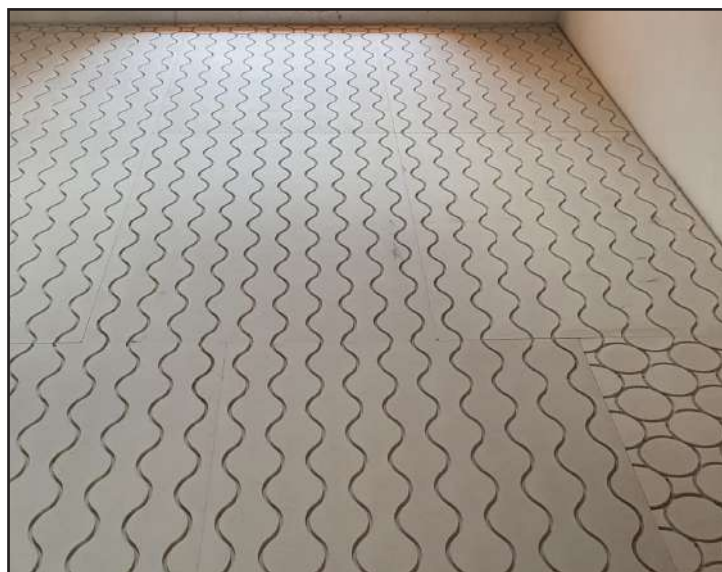
Posizionamento dei pannelli FinoTherm® in gessofibra preaccoppiati a pannello in fibra di legno
