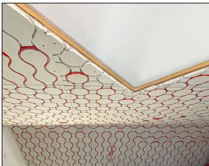
Dettaglio fissaggio dei pannelli FinoTherm ® su orditura in listelli di legno
