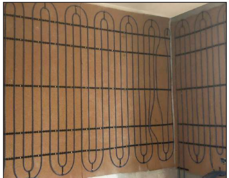
Fissaggio barre modulanti e tubazione su superfici curve e irregolari
