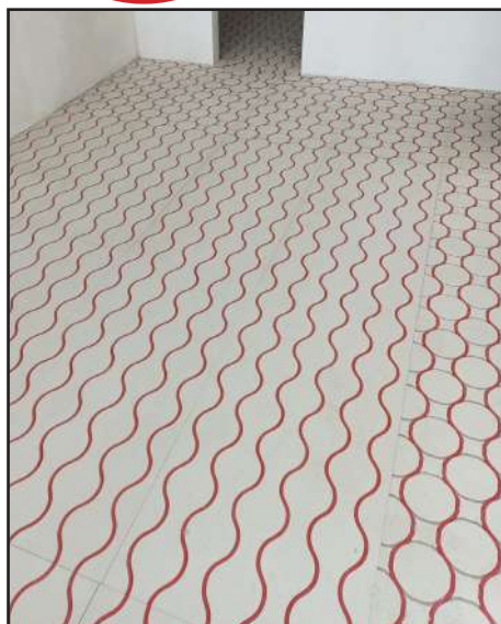
Dettaglio pannelli FinoTherm® a pavimento
