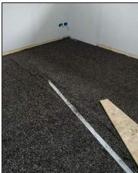
Distribuzione a secco sottofondo Isolfibra canapa con rastrello
