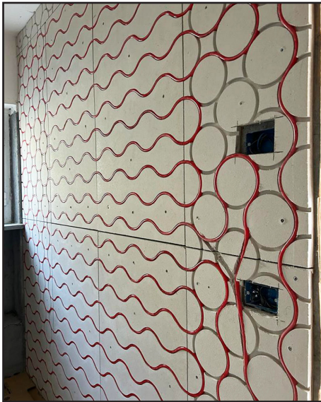
Posa della tubazione
