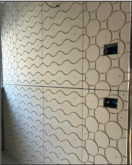
Dettaglio posa pannelli FinoTherm® in gessofibra a parete
