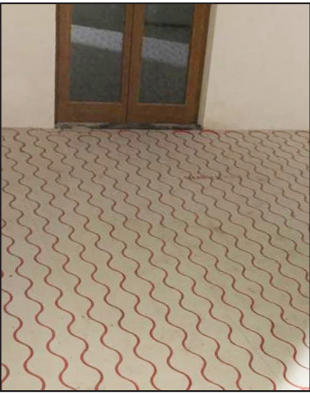
Dettaglio pannelli FinoTherm® standard posati
