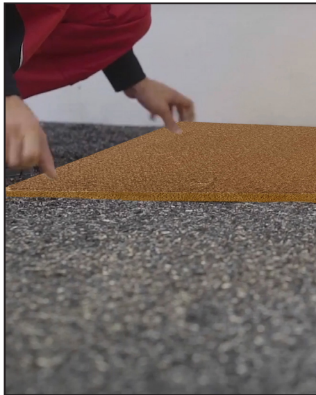
Posa pannello isolante in fibra di legno con compressione distribuita del sottofondo
