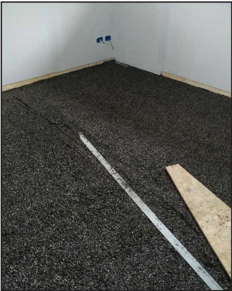
Distribuzione a secco sottofondo Isofibra canapa con rastrello
