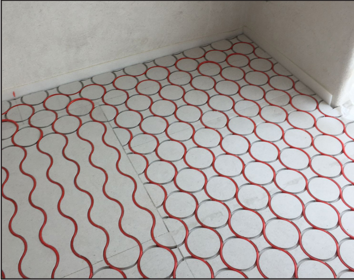
Posa della tubazione
